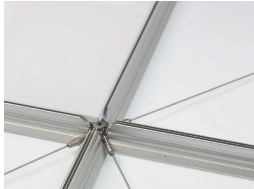
Äußerste Präzision im Detail zeigt pon media – wie alle Systeme von Burkhardt Leitner Modular Spaces. Die pon systeme sind Knoten-Stab-Systeme mit magnetischer Verbindung. Der intelligente Verbindungsknoten besteht aus Edelstahl-Feinguss, die Stäbe aus einer hochfesten und elastischen Aluminium-Sonderlegierung. Dies führt zu extrem hoher Biegefestigkeit bei sehr niedrigem Gewicht. Diagonalaussteifungen werden werkzeuglos mit den Knoten verbunden. Foto: Burkhardt Leitner Modular Spaces
